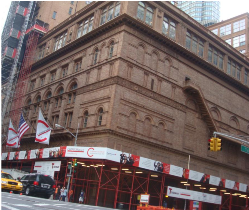
築120年、改装工事中のカーネギーホール
